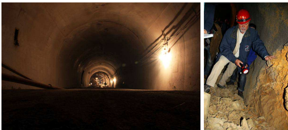
An der Huang Tupo-Rutschung, Links: der Hauptstollen unter der Gleitfläche; Rechts: Herr Prof. Schwingenschlögl am direkten Aufschluss der Gleitfläche in einem Seitenstollen [20.10.2011]
