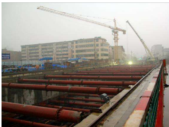
U-Bahnbau in Xi'an, Oben links: Der U-Bahn-Tunnel (Kalotten-Vortrieb) weitet sich im Stationsbereich auf; Oben rechts: im Bau-Container stellt man uns das Projekt im Detail vor; Unten links: Der im Cut and Cover-Verfahren hergestellte Stationsbereich; Unten rechts: Montagearbeiten an der Tunnelbohrmaschine [11.10.2011]
