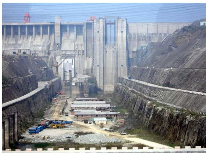
*Abb. 12: Schiffshebewerk im Bauzustand*
