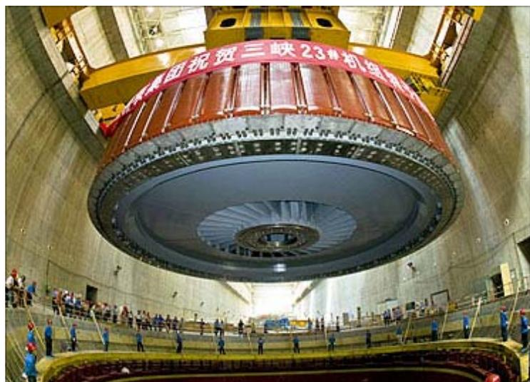
Abb. 17: Der Rotor eines Generators wird eingesetzt.
