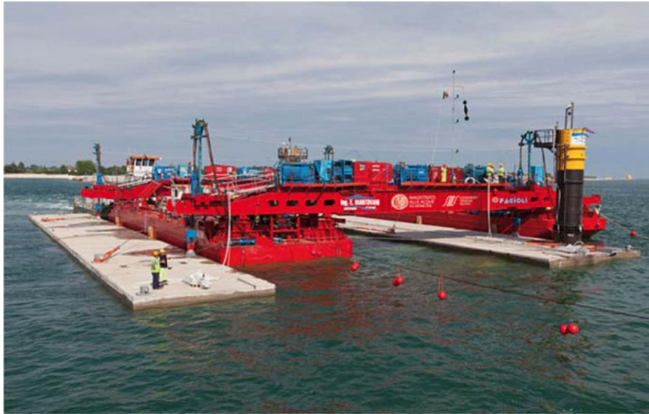
Abbildung 12: Transport der Fertigteile bis zum fixen Standort ( https://www.mosevenezia.eu )
