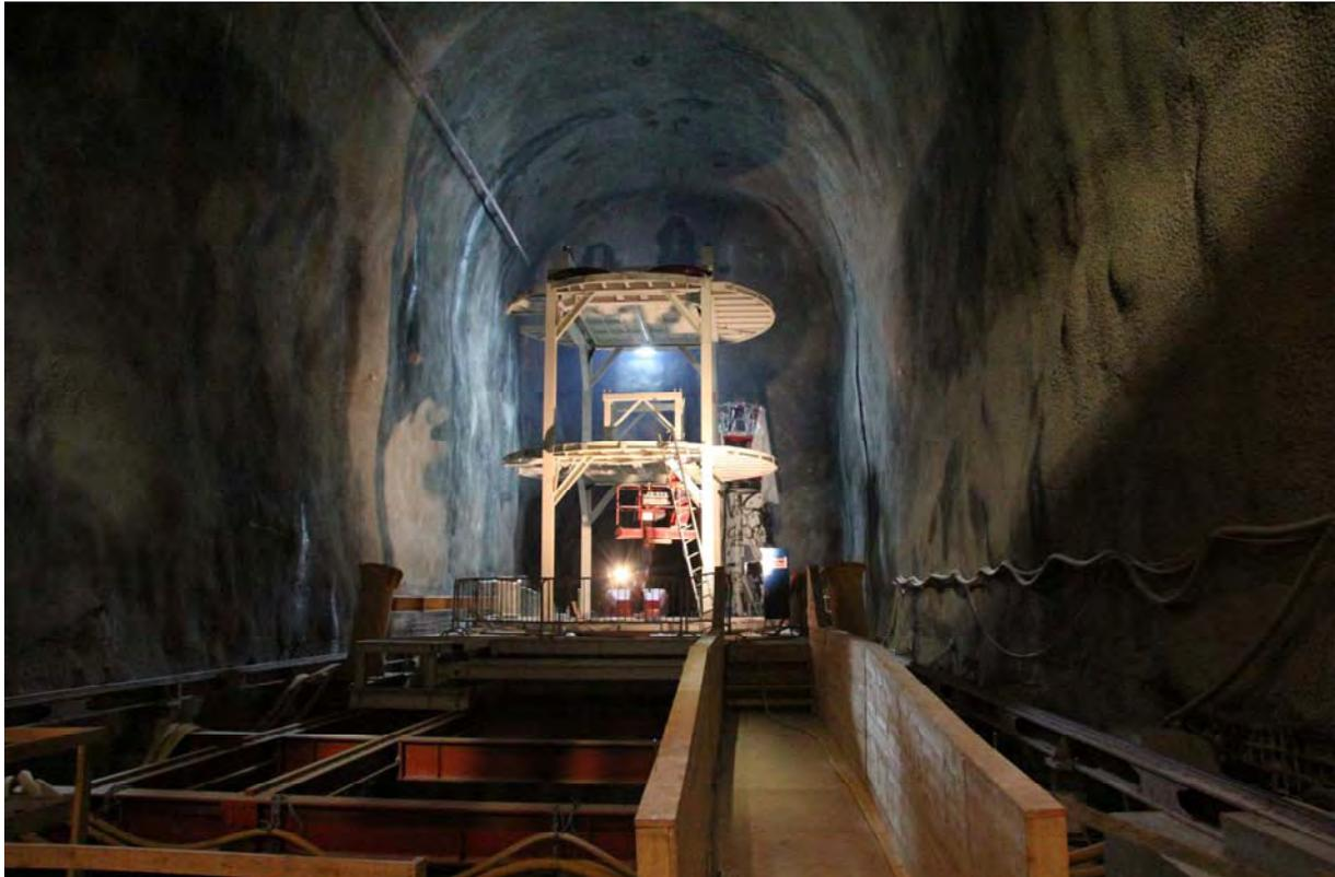
**Abbildung 14 Arbeitsbühne Vertikalschächte**
