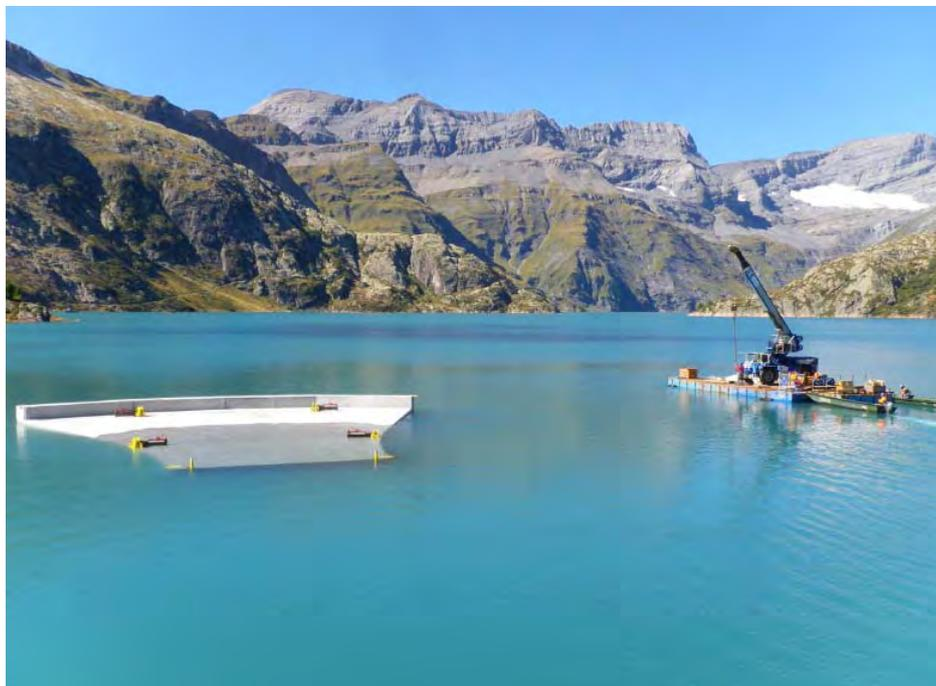
**Abbildung 17 Einschwimmen des Ein- und Auslaufbauwerks**
