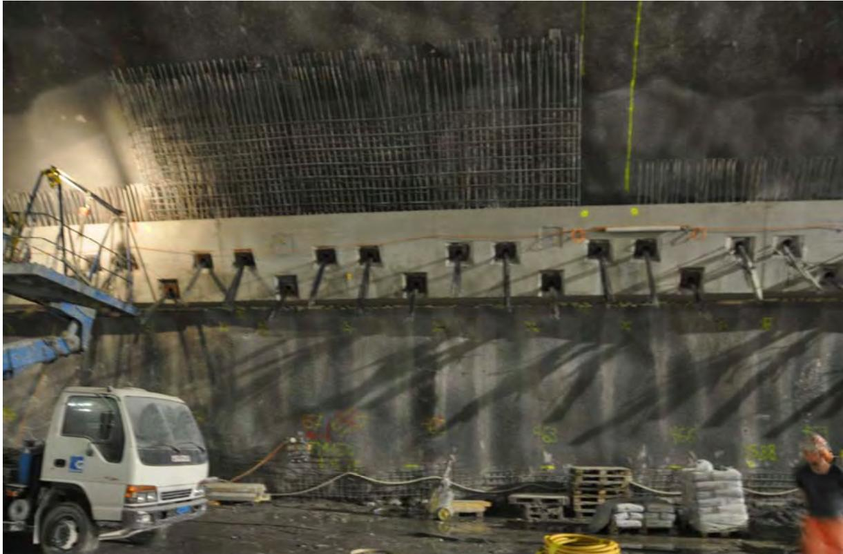
**Abbildung 11: Verankerung der Kranschiene**
