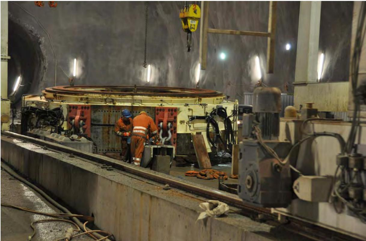
Abbildung 15 Letzte Elemente der TBM bei der Demontage
