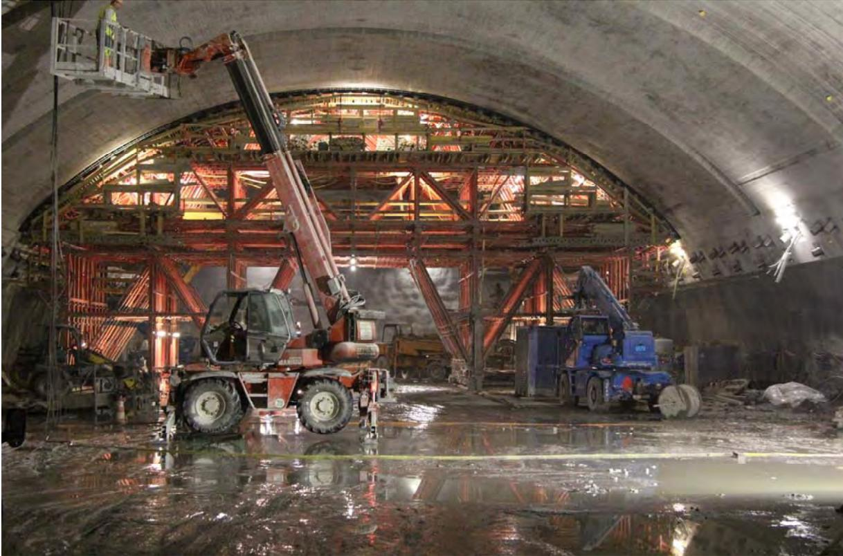
**Abbildung 5 Maschinenkaverne mit Schalwagen**
