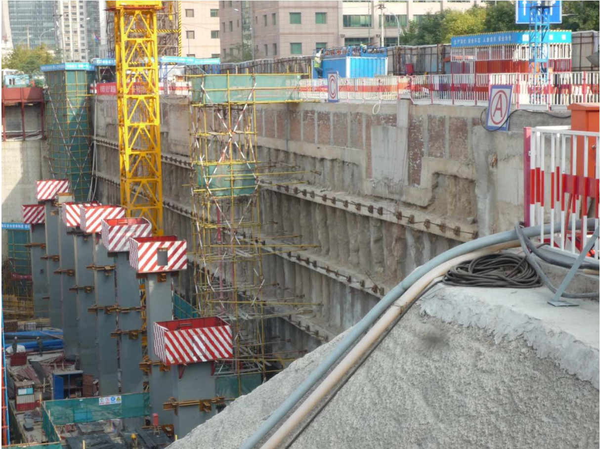
Abbildung 4.1: Bohrpfalwand mit Ankern
