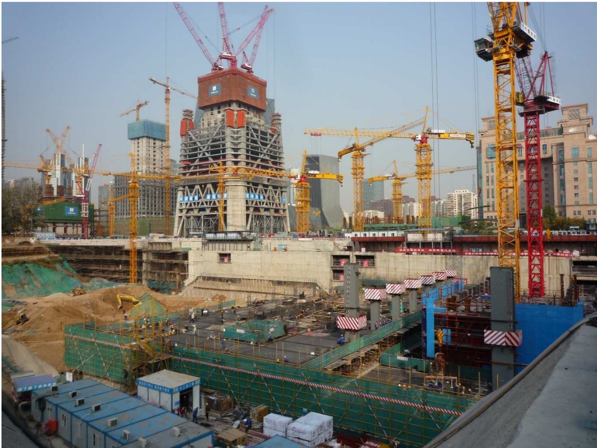
Abbildung 1.1: Übersicht Baustelle Peking
