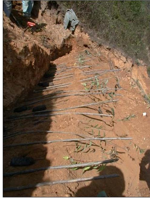
**Abbildung 17: Detail Heckenbuschlage (Thankot, Nov. 2002)**
