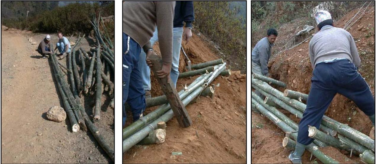
Abbildung 24, 25 und 26: Konstruktion einer Bambuskrainerwand (Thankot, Februar 2002)
