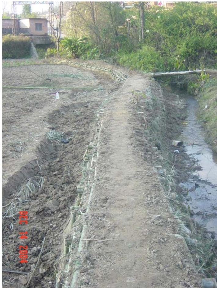
**Abbildung 15: Bambuskraimerwand als Uferschutzdamm an einem kleinen Fluss (Bhyalku) in Badikhel (Dezember 2004).**
