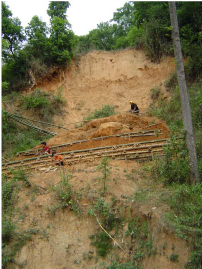
**Abbildung 6: Gesamtansicht des Hangrutsches über Badikhel, Fläche 2, Bau von Bambuskraimerwänden (Mai 2004)**
