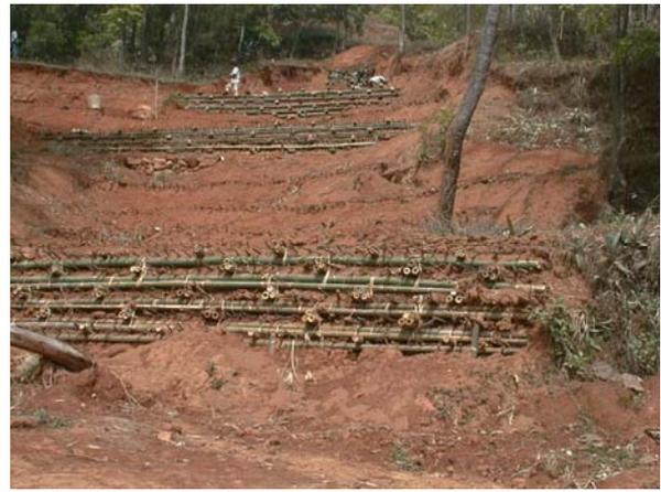
Abbildung 10: Oberer Teil Fläche 1 in Badikhel nach dem Bau von Bambuskraimerwände und Heckenbuschlagen (Blick von unten, Juni 2003).
