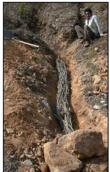
**Abbildung 18, 19 und 20: Konstruktion einer Drainfaschine , Thankot (Dezember, 2002)**
