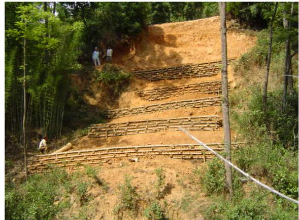
**Abbildung 14: Fläche 2 nach dem Bau von Bambuskraimerwände (Mai 2004), Badikhel**
