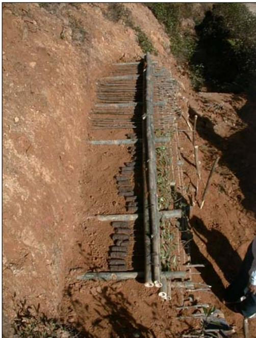
Abbildung 7: Detail Bambuskraimerwand 4 mit Pflanzeneinlage, Thankot, November 2002
