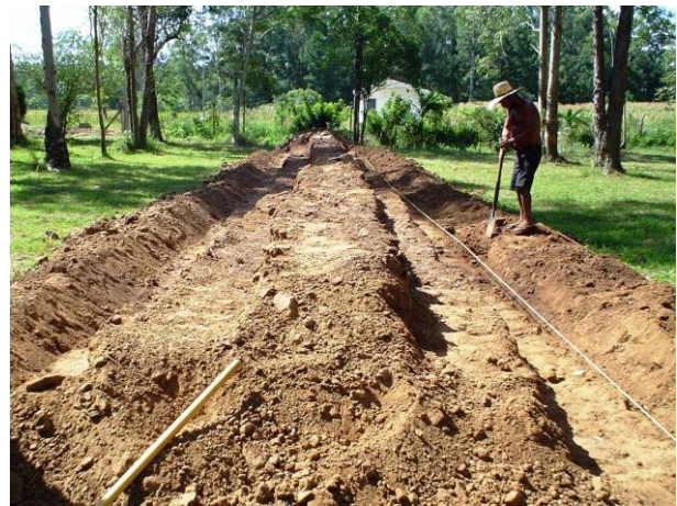
Abbildung 4.1.1.1: Errichtung des Versuchshügels am Arroio Guarda-mor (links), und im Versuchsgarten der Universität von Santa Maria (rechts).
