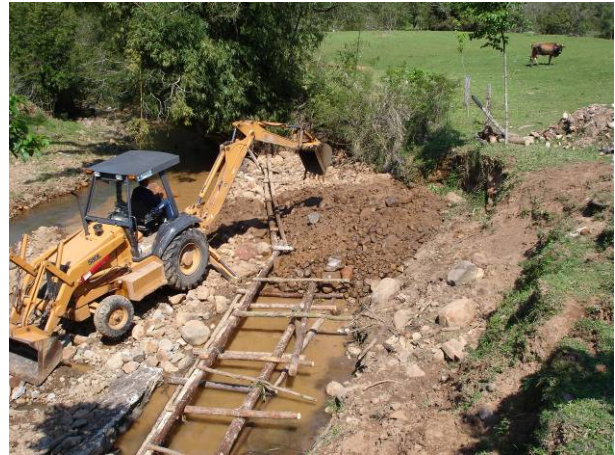
Abbildung 5.3.1.3: Bau der Holzkrainerwand als Fußsicherung (links) und Einschütten der Holzkrainerwand (rechts) – Arroio Vale Vêneto, Oktober 2005.
