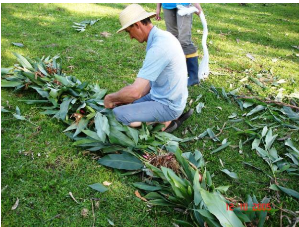
Abbildung 5.3.1.4: Binden (links) und Einbau der Kardamommus-Faschine in die Holzkrainerwand (rechts) – Arroio Vale Vêneto, Oktober 2005.
