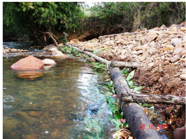
Abbildung 5.3.1.4: Binden (links) und Einbau der Kardamommus-Faschine in die Holzkrainerwand (rechts) – Arroio Vale Vêneto, Oktober 2005.
