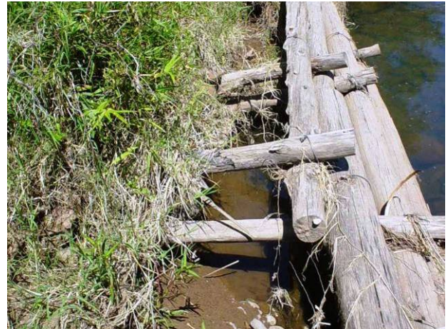
Abbildung 5.1.1.5: Fotodokumentation einen Tag nach dem Starkregen am 15.12.2005 (links) und Detail der Hinterspülung (rechts).
