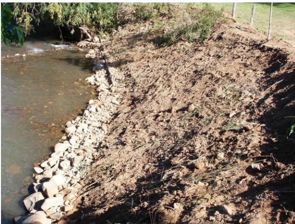
Abbildung 5.3.1.6: Fertige Spreitlage Ende Oktober 2005 (links) und nach 3 Monaten (Januar 2006, rechts) – Arroio Vale Vêneto.
