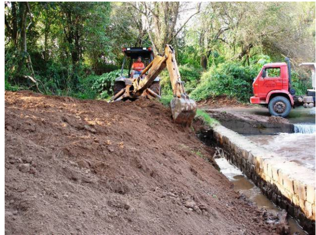
Abbildung 5.2.1.2: Abböschten des Steilufers am Rio Soturno, August 2005.
