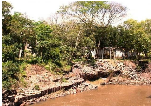
Abbildung 2.7.3: Gerinneausbaggerung nach starker Geschiebeumlagerung durch den Arroio Guarda-mor (links) und Versuch einer Uferstabilisierung mit schlecht gebauter Mauer in Rio Vacacaí Mirim (rechts).
