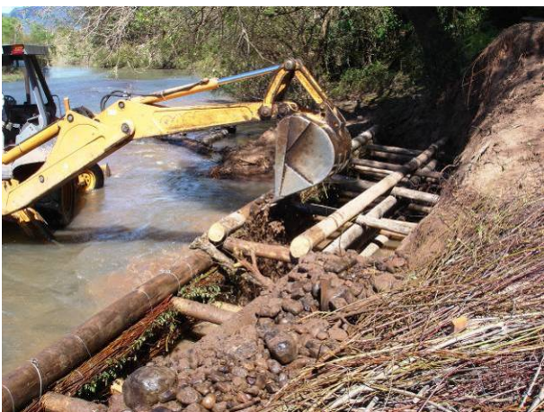
Abbildung 5.2.1.11: Einschütten der Uferkainerwand, zuerst mit Grobkies (links) und letztendlich mit Erdmaterial der Abböschung (rechts) – Rio Soturno, September 2005.
