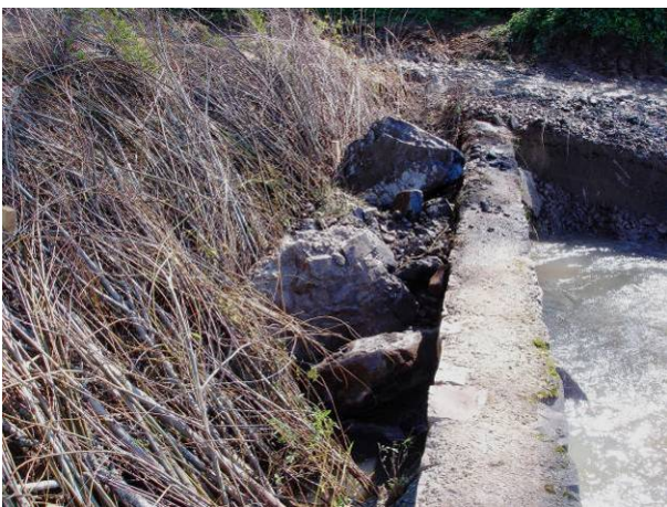
Abbildung 5.2.1.5: Steinhinterfüllung zwischen Mauer und Spreitlage – Rio Soturno, August 2005.
