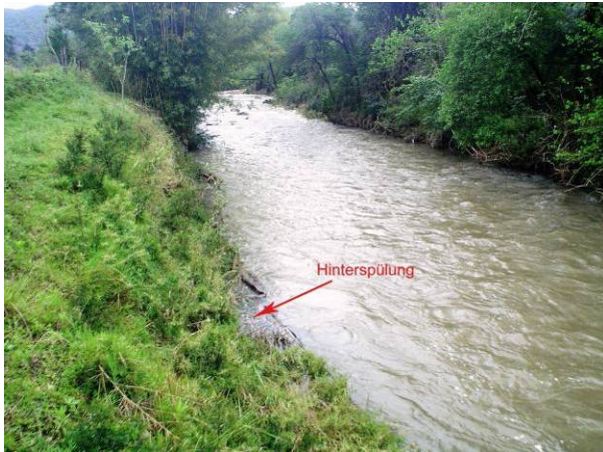
Abbildung 5.1.1.5: Fotodokumentation einen Tag nach dem Starkregen am 15.12.2005 (links) und Detail der Hinterspülung (rechts).
