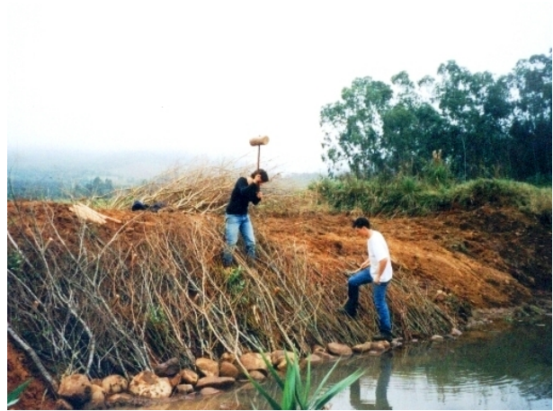
Abbildung 5.1.2.3: Abböschten des Steilufers (links) und das Einschlagen der Pflöcke der Spreitlage für das Anbinden (rechts) – August 2003, Arroio Guarda-mor.
