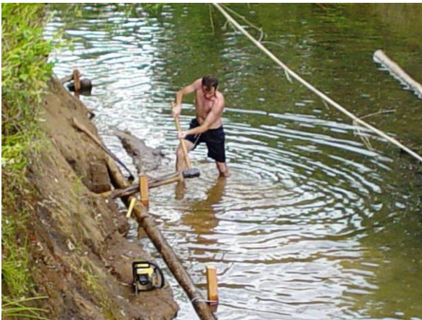
Abbildung 5.1.1.3: Baubeginn (links) und die ersten zwei Längsholzreihen (rechts) der einfachen Uferkainerwand am Arroio Guarda-mor – Februar 2003.
