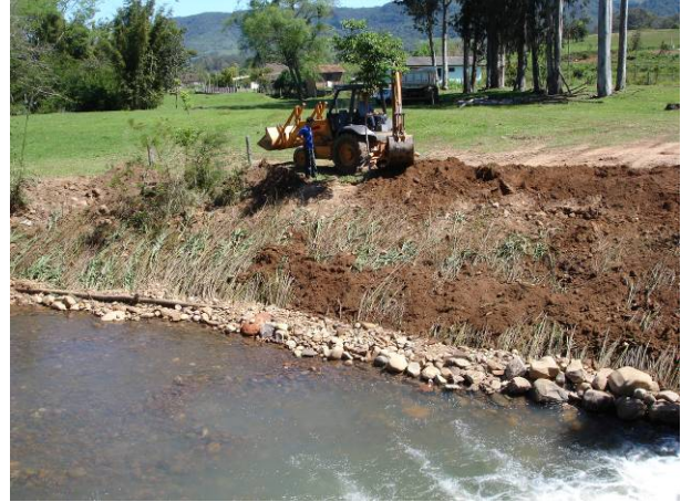
Abbildung 5.3.1.5: Befestigung (links) und Abdeckung der Spreitlage (rechts) – Arroio Vale Vêneto, Oktober 2005.
