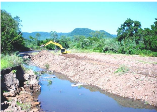
Abbildung 2.7.3: Gerinneausbaggerung nach starker Geschiebeumlagerung durch den Arroio Guarda-mor (links) und Versuch einer Uferstabilisierung mit schlecht gebauter Mauer in Rio Vacacaí Mirim (rechts).
