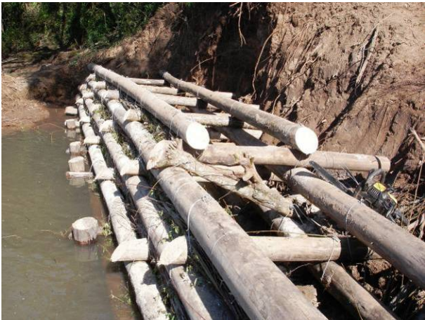
Abbildung 5.2.1.10: Fertige Uferkainerwand (links), Detail (rechts) – Rio Soturno, August 2005.
