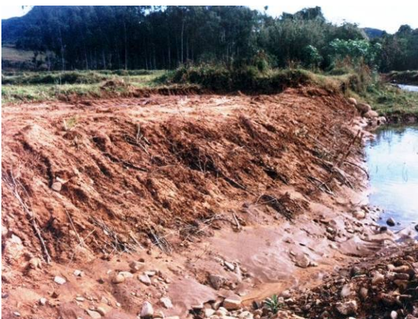
Abbildung 5.1.2.4: Fertige Spreitlage mit sandigem Lehm abgedeckt nach einem Niederschlag von 70 mm (20.08.'03 – links) und nach einem Monat (20.09.'03 – rechts), Arroio Guarda-mor.
