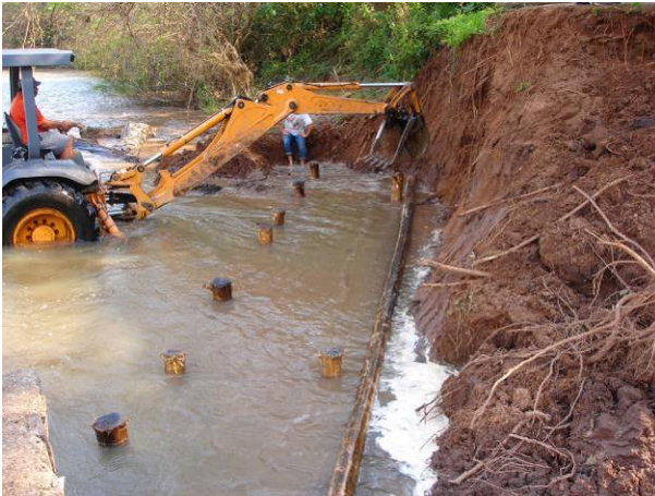
Abbildung 5.2.1.7: Baubeginn der Uferkranerwand am Rio Soturno, August 2005 – Einschlagen der Holzpiloten mit Bagger (links) und Einschlagen der Querhölzer (rechts).
