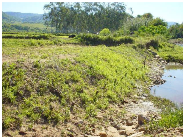
Abbildung 5.1.2.4: Fertige Spreitlage mit sandigem Lehm abgedeckt nach einem Niederschlag von 70 mm (20.08.'03 – links) und nach einem Monat (20.09.'03 – rechts), Arroio Guarda-mor.
