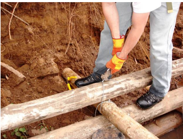
Abbildung 5.2.1.8: Nachspannen des Drahtes mit einer Bindezange (links) und weiterer Aufbau der Uferkranerwand (rechts) Rio Soturno, August 2005.
