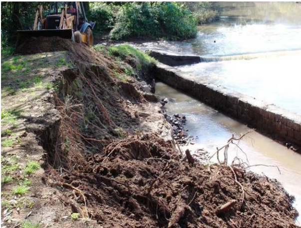
Abbildung 5.2.1.2: Abböschten des Steilufers am Rio Soturno, August 2005.
