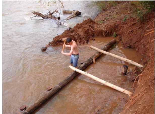
Abbildung 5.2.1.7: Baubeginn der Uferkranerwand am Rio Soturno, August 2005 – Einschlagen der Holzpiloten mit Bagger (links) und Einschlagen der Querhölzer (rechts).
