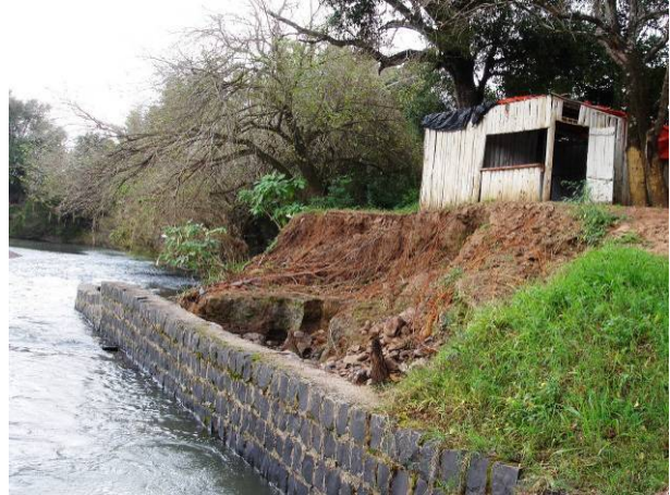
Abbildung 5.2.1.1: Erodiertes Gleitufer am Rio Soturno – Juli 2005.
