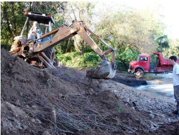
Abbildung 5.2.1.6: Abdeckung der Äste mit Erdmaterial – Rio Soturno, August 2005.
