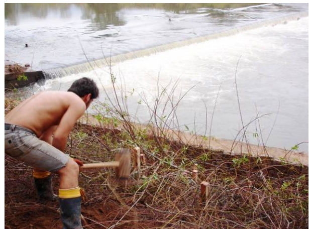
Abbildung 5.2.1.3: Auflegen des Pflanzenmaterials unter die Wasseranschlaglinie (links) und Einschlagen der Pflöcke (rechts) – Rio Soturno, August 2005.
