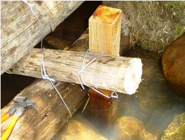
Abbildung 5.1.1.4: Detail der Drahtbefestigung (links) und Bild unmittelbar nach Fertigstellung – März 2003 – der einfachen Uferkainerwand und nach dem Abböschchen der Steilufer (rechts).
