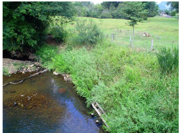
Abbildung 5.3.1.6: Fertige Spreitlage Ende Oktober 2005 (links) und nach 3 Monaten (Januar 2006, rechts) – Arroio Vale Vêneto.
