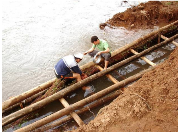
Abbildung 5.2.1.9: Binden der Faschinen (links) und Einbauen der Faschinen in die Uferkainerwand (rechts) – Rio Soturno, August 2005.
