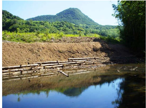
Abbildung 5.1.1.4: Detail der Drahtbefestigung (links) und Bild unmittelbar nach Fertigstellung – März 2003 – der einfachen Uferkainerwand und nach dem Abböschchen der Steilufer (rechts).
