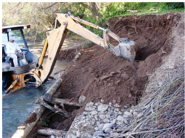
Abbildung 5.2.1.11: Einschütten der Uferkainerwand, zuerst mit Grobkies (links) und letztendlich mit Erdmaterial der Abböschung (rechts) – Rio Soturno, September 2005.
