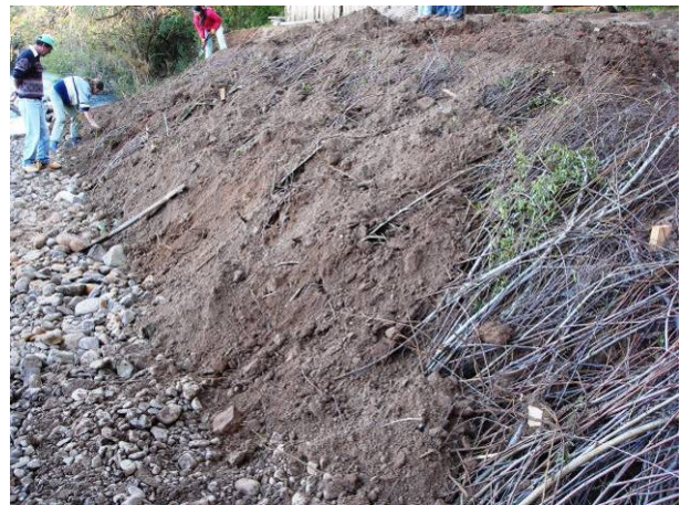
Abbildung 5.2.1.6: Abdeckung der Äste mit Erdmaterial – Rio Soturno, August 2005.
