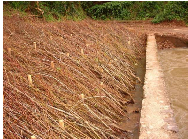
Abbildung 5.2.1.4: Nachschnitt der Pflöcke (links) und befestigte Spreitlage (rechts) – Rio Soturno, August 2005.
