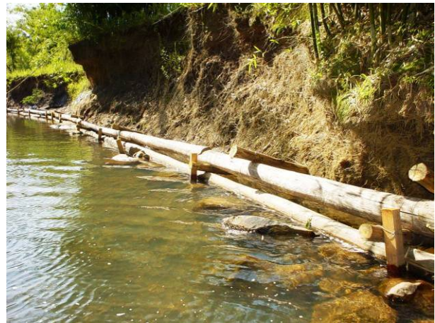
Abbildung 5.1.1.3: Baubeginn (links) und die ersten zwei Längsholzreihen (rechts) der einfachen Uferkainerwand am Arroio Guarda-mor – Februar 2003.
