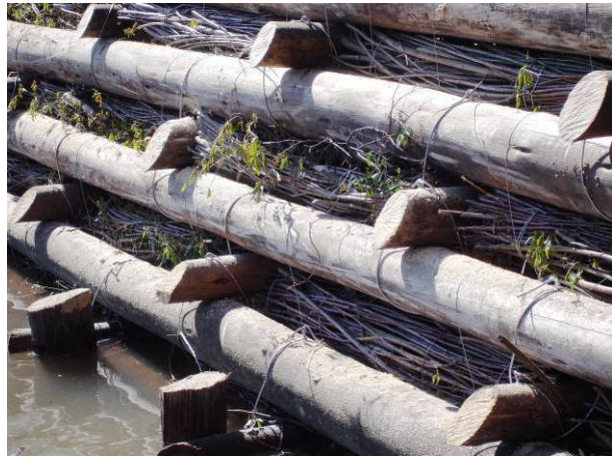
Abbildung 5.2.1.10: Fertige Uferkainerwand (links), Detail (rechts) – Rio Soturno, August 2005.
