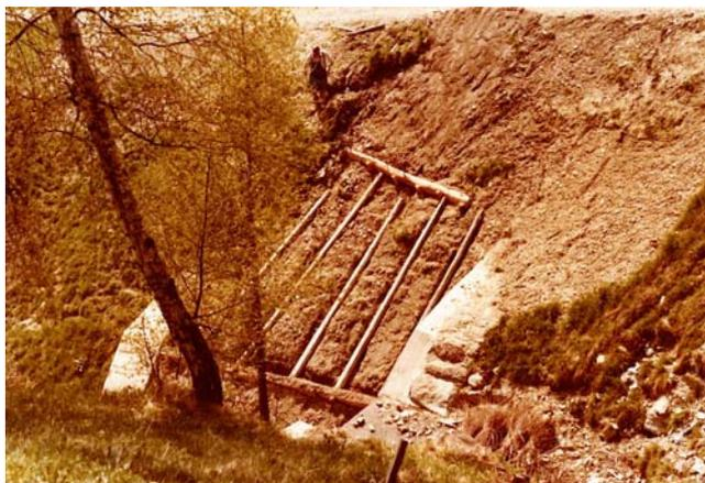
Abb. 105: Stabilisierung der Bachböschung 1981
