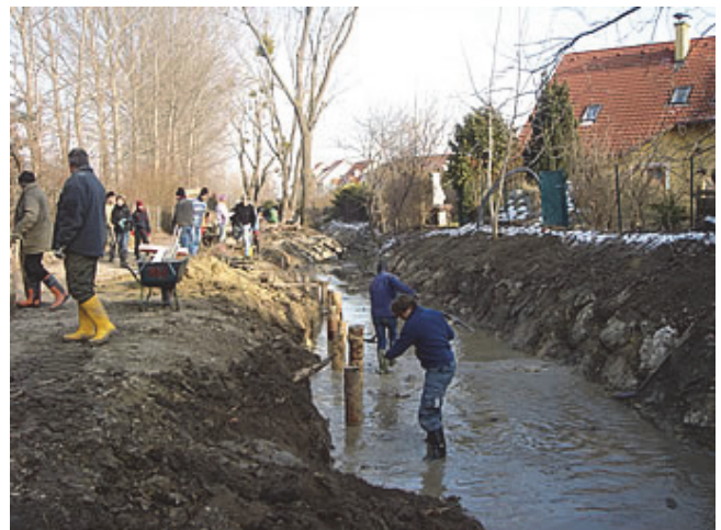
Studierende beim Bau einer Faschinenwand
