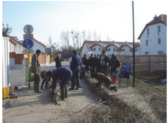
Studierende beim Bau einer Weidenfaschine
