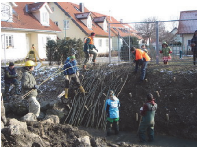
Studierende beim Bau einer Weidenfaschine
