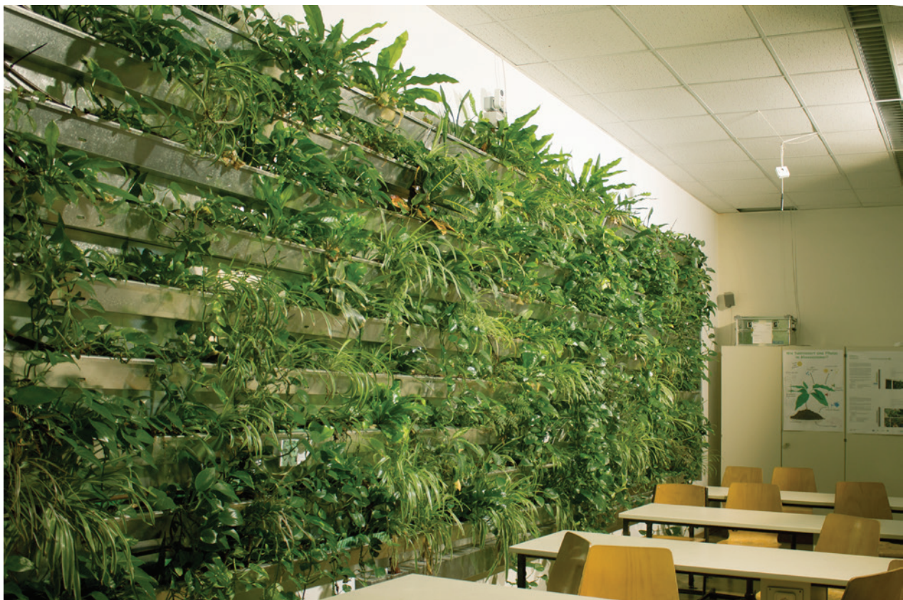
Abb. 12: Aluminiumtrogssystem im Biologiesaal.
