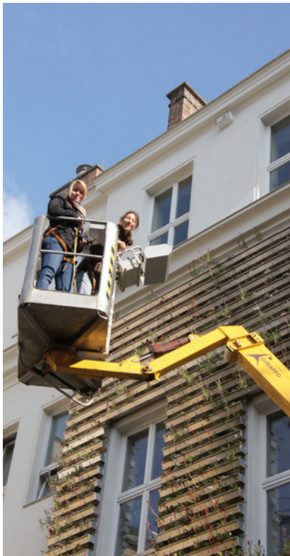
Abb. 29: Pflege der Grünfassade mit dem Hubsteiger.
