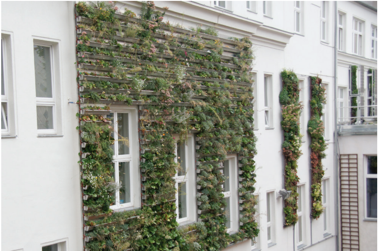
Abb. 21: unterschiedliche Fassadenbegrünungssysteme im Innenhof.
