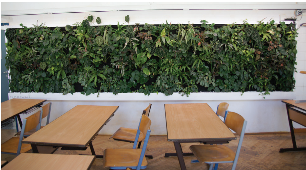
Abb. 14: Vliessystem im Klassenraum.
