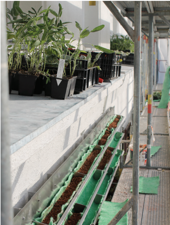
Abb. 5: Bepflanzung der Außenfassade mit Gerüst.
