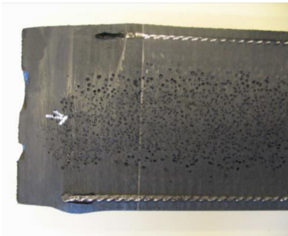
Bild 1 Schlupf der Stahlbewehrung bei Biegeversuchen an Balken aus recyceltem Kunststoff. Slippage of the steel reinforcement in recycled plastic beam subjected to bending.
