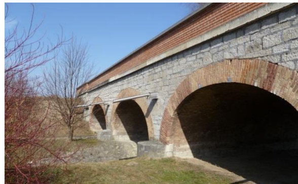
Bild 2 Gewölbe des Fallbeispiels. Vaults of the case study object.
