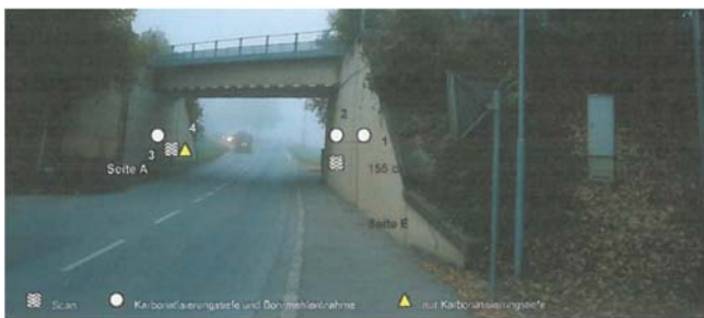
Abbildung 1: Ansicht der Brücke [1]
