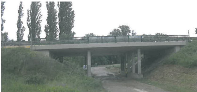
Abbildung 1: Ansicht der Brücke [1]
