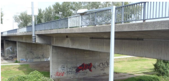
Abbildung 1: Ansicht der B0209 – Baulos F – Ka
