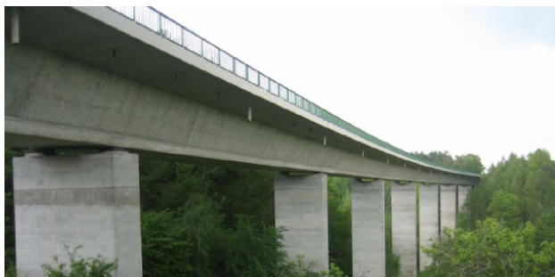
Abbildung 1: Ansicht der Brücke
