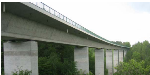
Abbildung 1: Ansicht der Brücke
