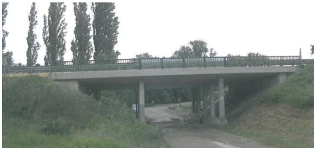
Abbildung 1: Ansicht der Brücke [1]
