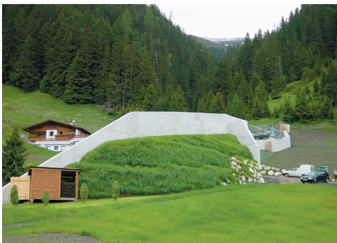
Bild 4 Lawinenablenkmauer Lanersbach Ansicht talseitig
