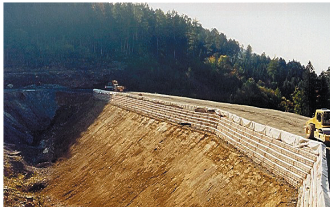
Bild 1 Bau der geotextil-verstärkten Krone (Foto: M. Scheibner, ILF)
