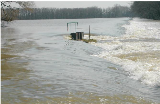
Bild 1: Überströmung eines Dammes und Dammbbruch an der March im März 2006
