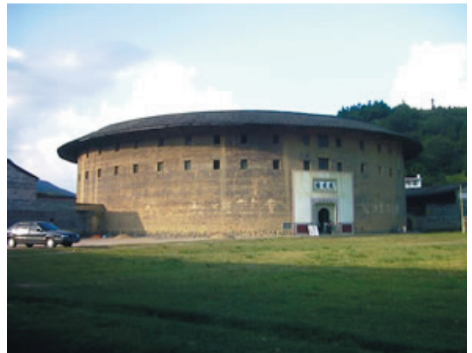
Bild 2: Denkmalgeschützter Lehmstampfbau in Südchina aus dem 17. Jahrhundert
