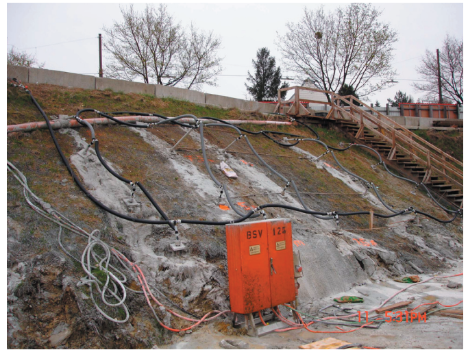
Bild 2: Schema der Energievlies Testanlage im Lainzer Tunnel LT 22-Bierhäuselberg (Quelle: R. Markiewicz) und Foto der Energieanker Testanlage im Lainzer Tunnel LT 31-Klimtgasse.
