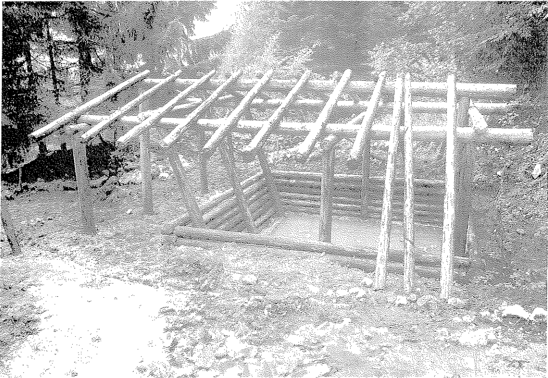
Abb. 3. Im Rahmen eines EU-Projektes rekonstruiertes, als Pökelwanne gedeutetes Blockwandbecken mit Flugdach vor der Eindeckung mit Legschindeln (Foto W. Lobisser).
