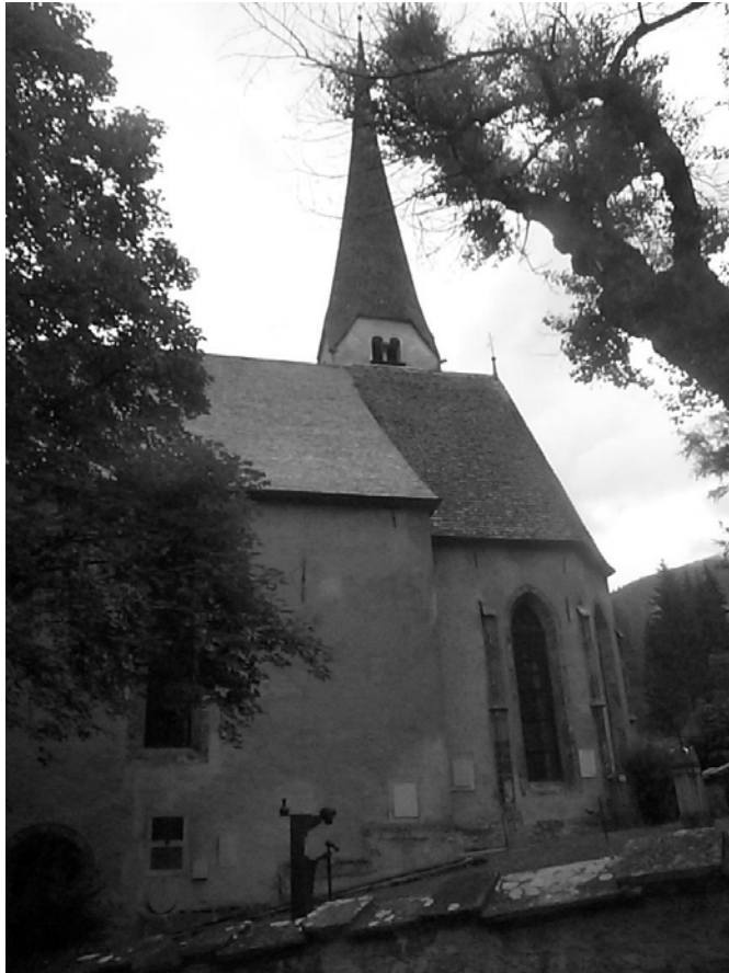
Abb. 17: Außenansicht der Nikolauskirche in Badgastein
