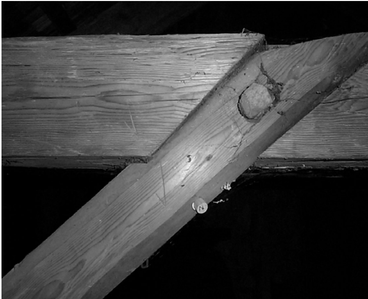
Abb. 10: Beprobungstelle an einer Strebe mit Abbundzeichen
