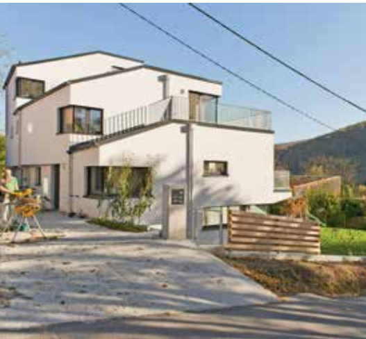
Das Passivhaus in Südhanglage wurde nach den Kriterien des solaren Bauens geplant.
