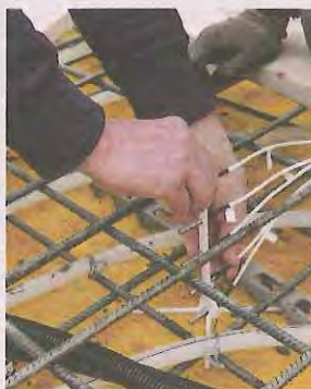
Bauarbeiter beim Verlegen der Bauteilaktivierung, Bild rechts: der Temperaturfühler
