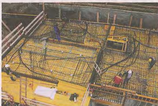
Bauarbeiter beim Verlegen der Bauteilaktivierung, Bild rechts: der Temperaturfühler
