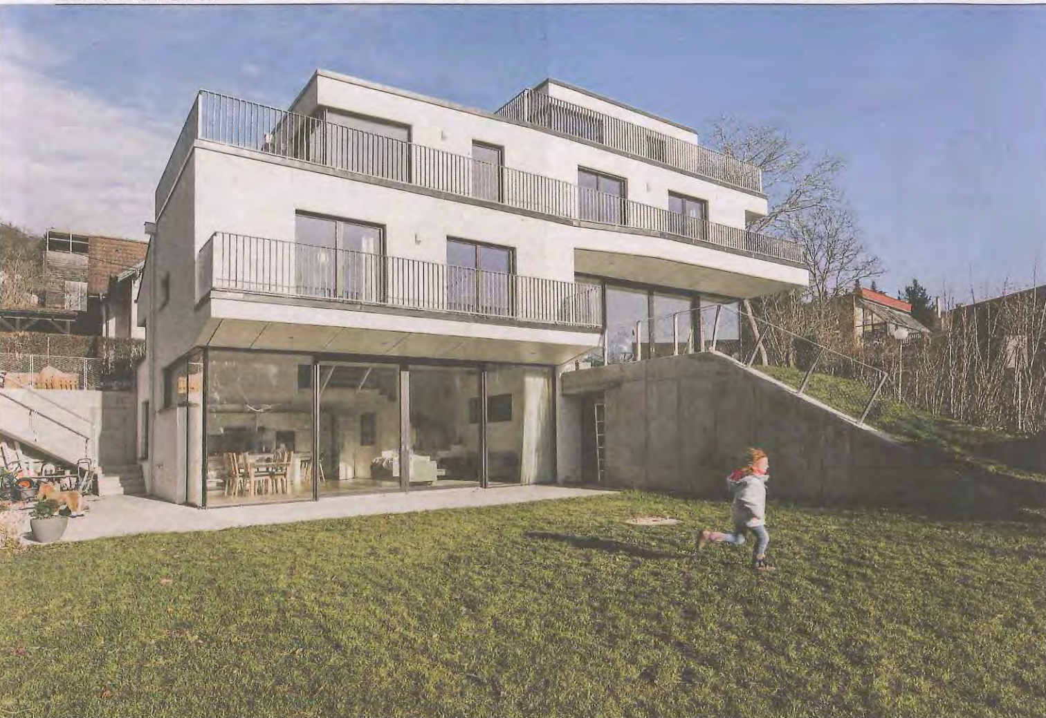
Im Winter scheint die tief stehende Sonne direkt in den Wohnraum, im Sommer wirft der Balkon einen Schatten, der den Wohnraum vor Hitze schützt
