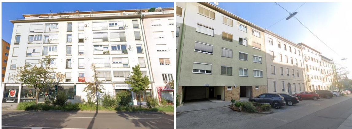
Abbildung 4: Fassadenansicht Bahnhofsgürtel (links) und Ghegagasse (rechts)
