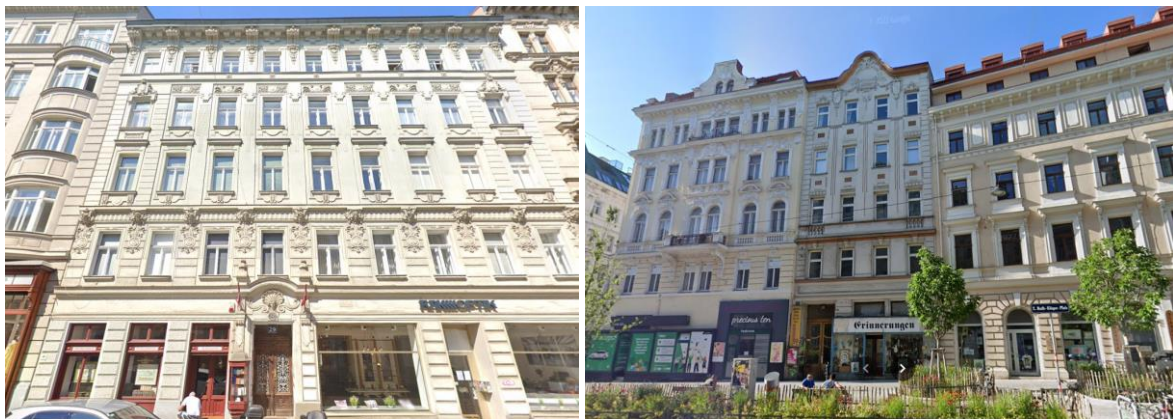
Abbildung 4: Fassadenansicht Kirchengasse (links) und Burggasse (rechts)
