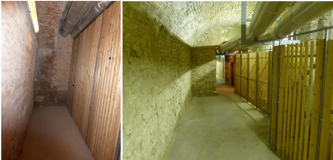
Abbildung 15: Beispielhafte Leitungsführung durch Untergeschoße (Quelle: V+P)
