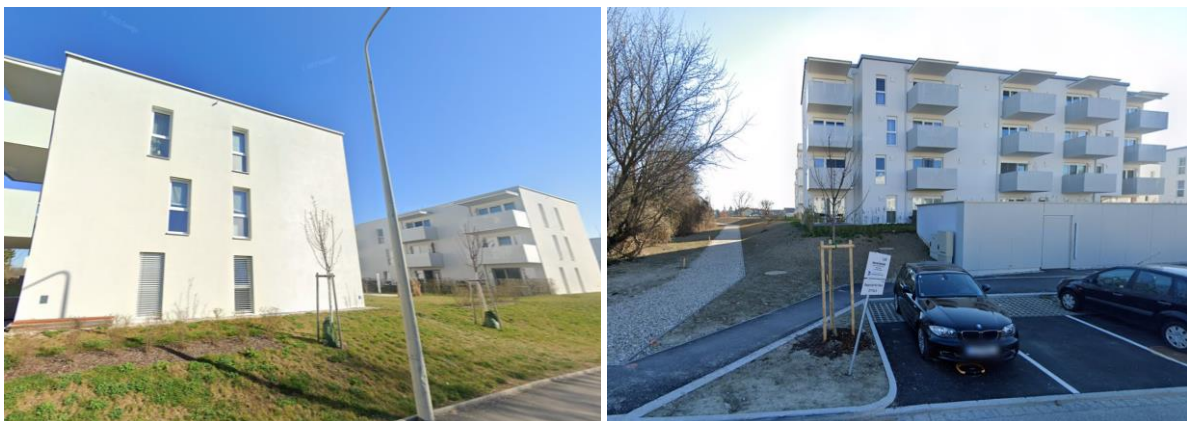
Abbildung 4: Fassadenansicht Traundorfer Straße (links) und Neufelder Straße (rechts)
