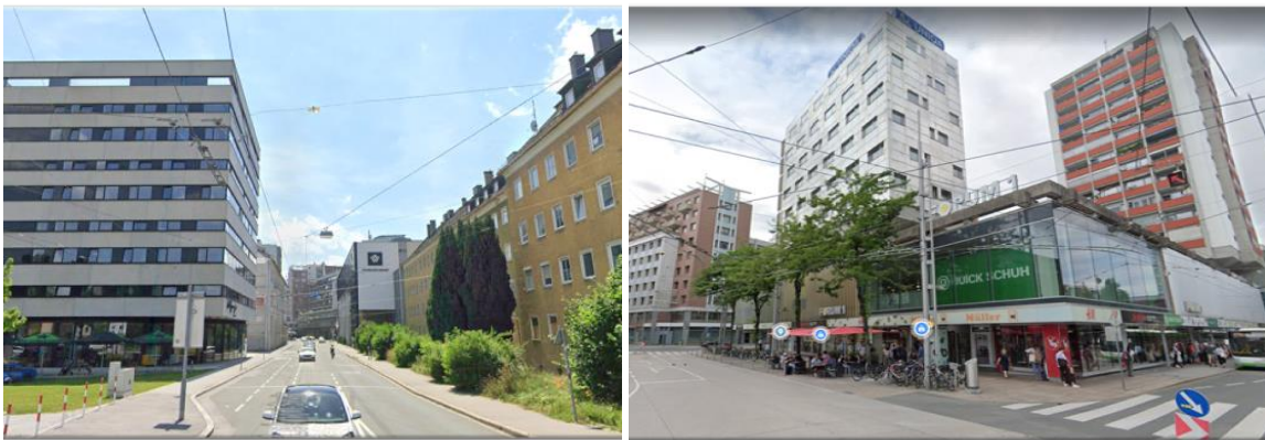
Abbildung 4: Fassadenansicht Fanny-von-Lehnert-Straße (links) und Karl-Wurmb-Straße (rechts)
