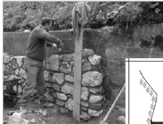
posa prime pietre e riempimento
