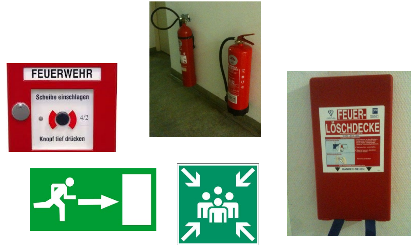
Feuerwehr-Alarm, Feuerlöscher, Feuerlöschdecke, Fluchtweg, Sammelplatz
