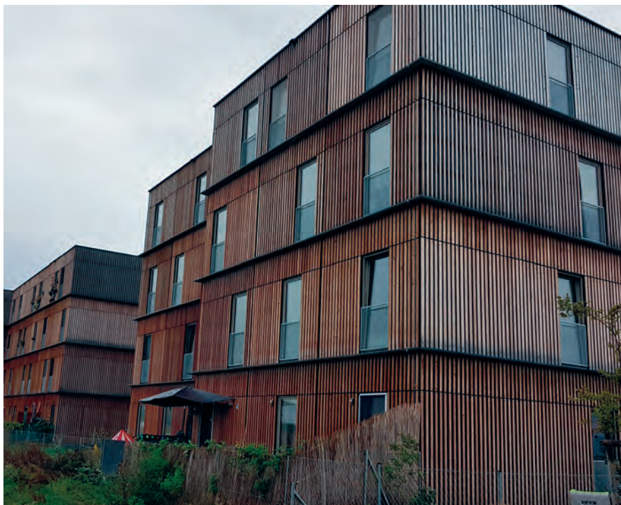
Die temporäre Wohnanlage in der Podhagskygasse im 22. Bezirk, eines der Pionierprojekte des Sofortwohnbauprogramms der Stadt Wien.
