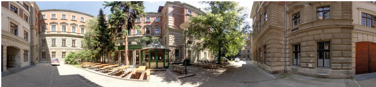
Innenhof des Gregor-Mendel-Hauses und Justus von Liebig-Hauses vor dem Umbau
