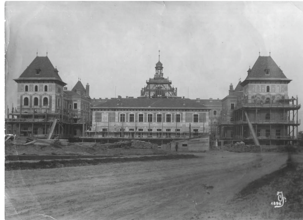
BOKU Hauptgebäude, Bau 1896
