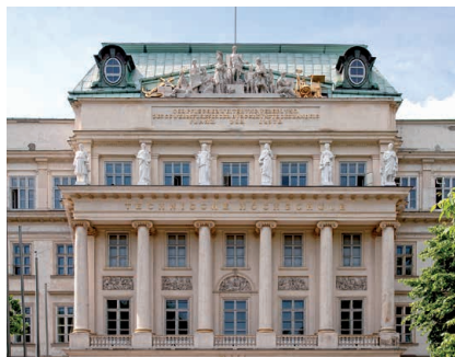
TECHNISCHE UNIVERSITÄT WIEN, HAUPTGEBÄUDE © TU Wien
