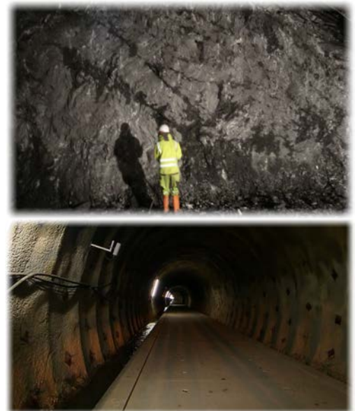
Abb. 2.1 und Abb. 2.2: Ortsbrust mit Wasseraustritten entlang von Klüften (oben Vortrieb, unten ausgebauter Erkundungsstollen Brenner Basistunnel, Fotos Klaus Voit)
