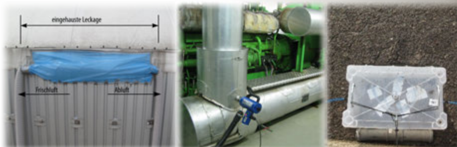
Abb. 1: Beispiel eines Messaufbaus an einer Leckage am Übergang der Behälterwand zum Foliendach (links); Probenahme Abgas Blockheizkraftwerk (Mitte), Haubenmessung bei einem offenen Gärrestlager (rechts)
