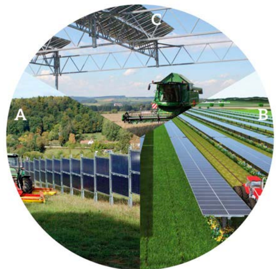
Abb. 1: Vertikal aufgestelltes bi-faziales APV-System (A), am Boden aufgeständertes tracking APV-System (B), aufgeständertes APV-System (C)
