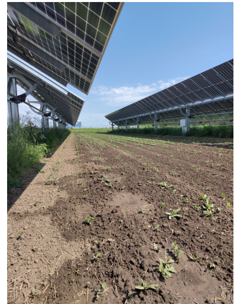
Abb. 3. Bodenfeuchte bei Tracking-Systemen. Trockenheit unter den Paneelen und Verschlämmung im Bereich der Abtropfkante.
