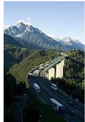
Source Wikimedia Commons Richard Hilber: Europabrücke von osten
