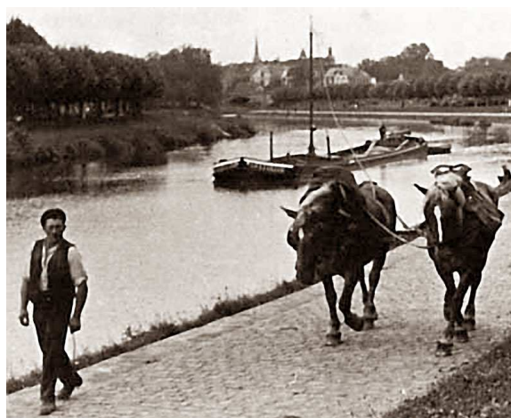
Alter Wiener Treppelweg
