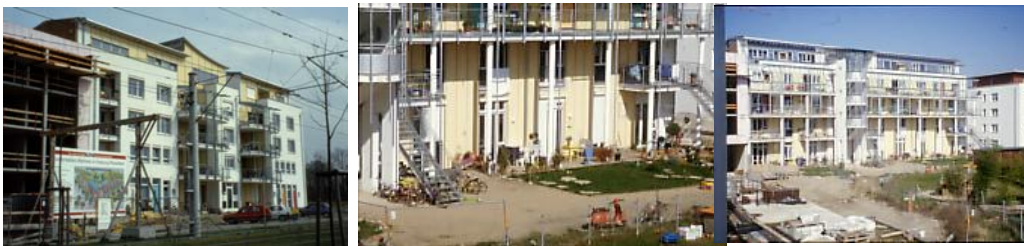
Fig. 2: Pictures from suburb Rieselfeld, Freiburg im Breisgau
