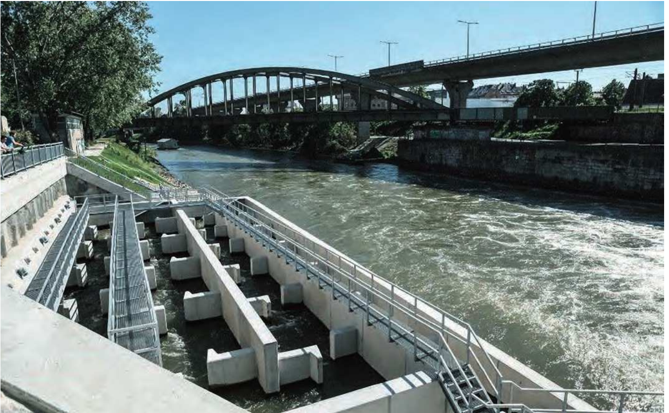
Fischaufstiegshilfe am Donaukanal – Kraftwerk Nussdorf
